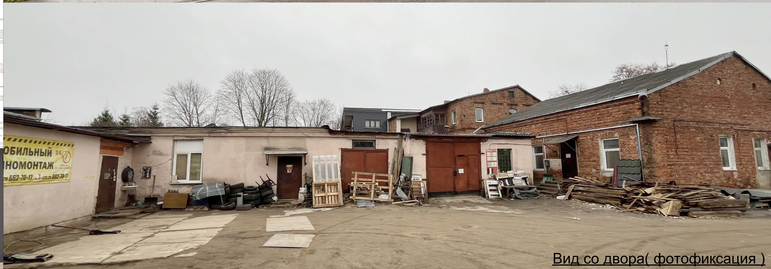
Вид со двора( фотофиксация )
