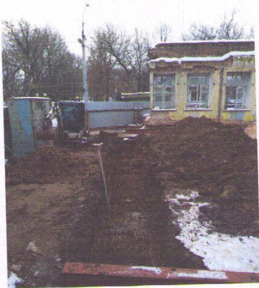
Фото 3. Витебск, 2020. Вид на траншею с севера
